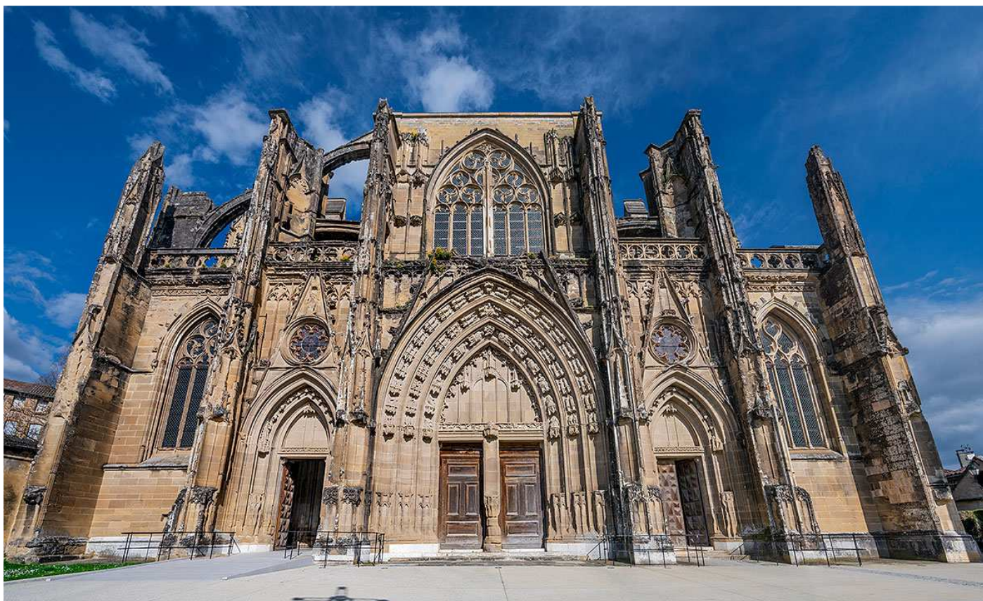
Vue du portail occidental de l'église avant restauration, 2019 © Crossos – Musée de Saint-Antoine-l'Abbaye
