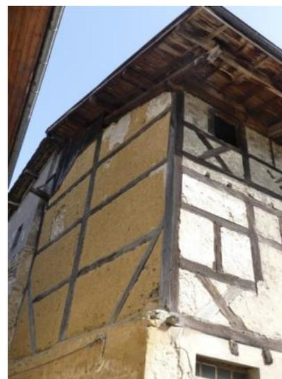
Le pisé : c'est un mélange de terre crue, de sable (ou de gravier) et d'argile, malaxé puis compacté. Le mur est monté directement depuis le sol à l'aide d'étais, contrairement aux constructions en briques (façonnées et cuites avant d'être empilées pour monter le mur). Ce procédé permet la construction de maisons en terre sans le soutien de pièces de bois.
