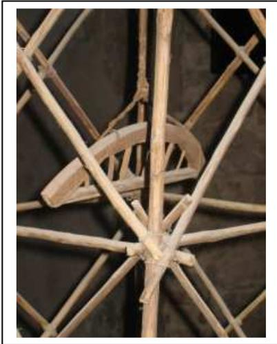
Les charpentiers passent alors à l'assemblage au sol des **fermes**, ce sont les structures triangulaires de la charpente qui supporteront la toiture. Les fermes sont hissées poutre par poutre jusqu'aux combles, montées et fixées à leur emplacement définitif à l'aide de chevilles de chêne, aucun clou n'entre dans leur fabrication, avant d'être enduites de goudron.
