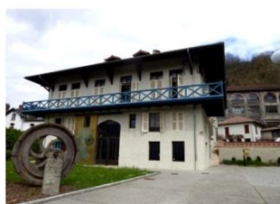
MAISON BERGÈS VILLARD-BONNOT
